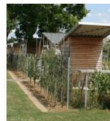
Abri de jardin Structure bois, bardage bois et bac acier
